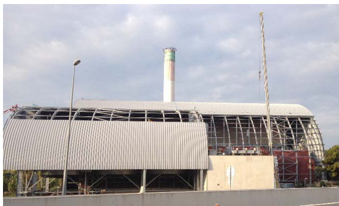
Travaux Unité de Valorisation Énergétique – Lagoubran – Toulon
